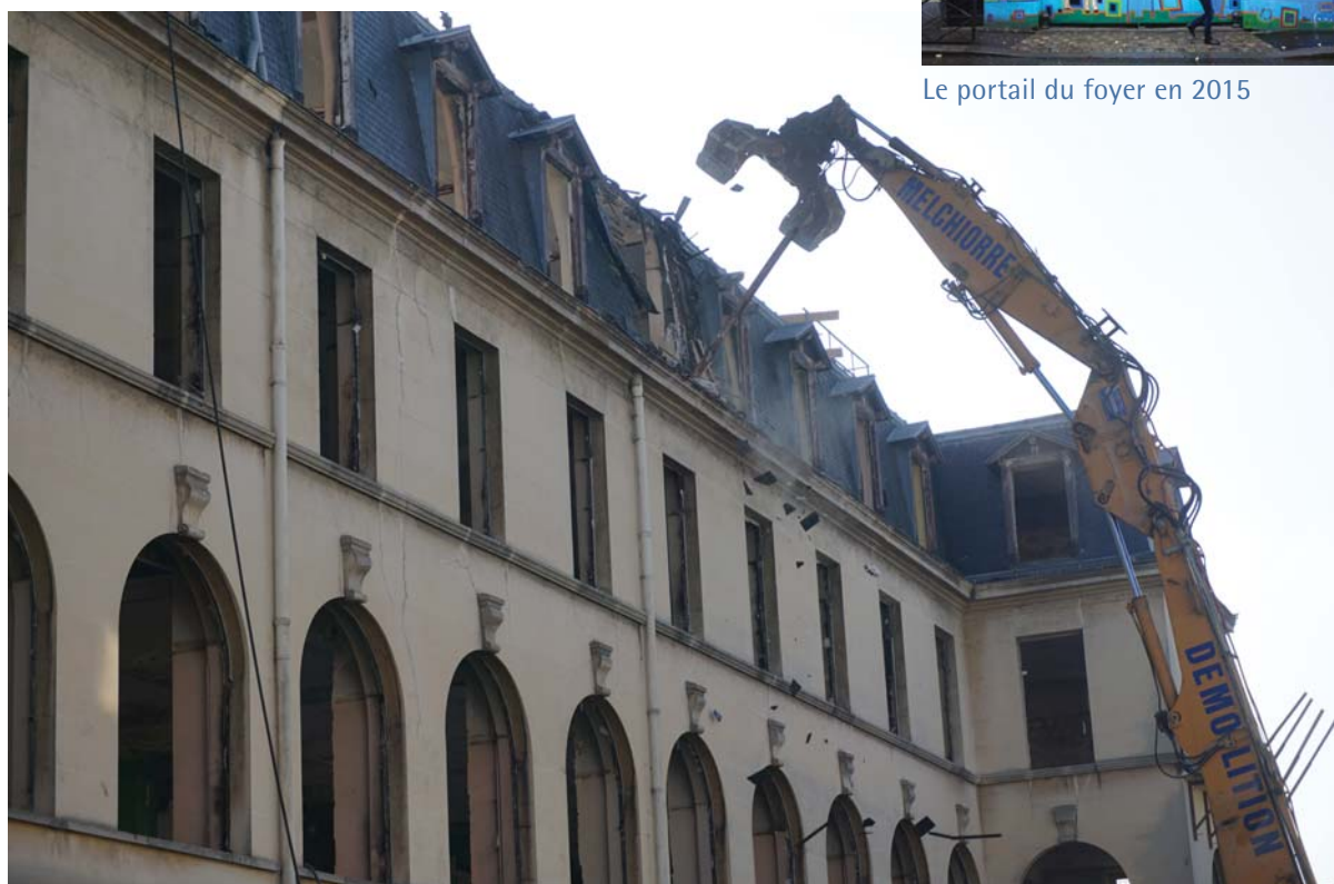
La façade démolie et sa balustrade le mois dernier.
