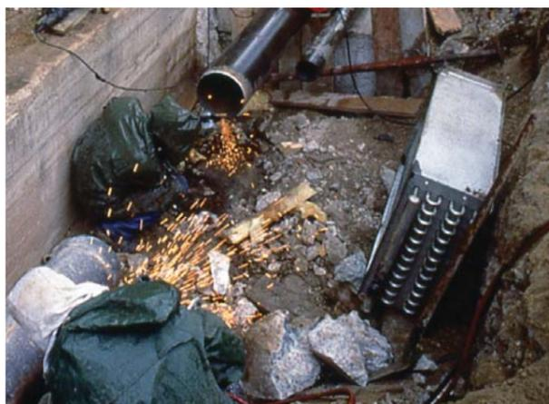
Soudure de tuyauterie en tranchée
