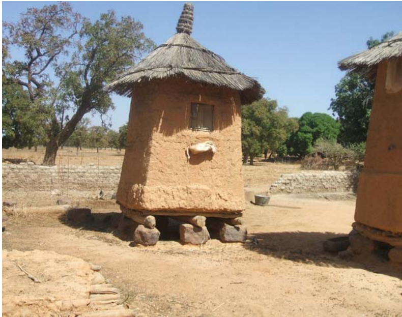
Un petit (2 mètres sur 1) grenier à mil, un abri pour la survie familiale
