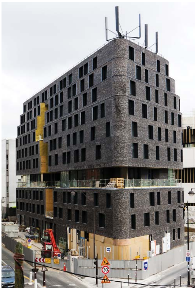
Les nouvelles éoliennes de la porte des Lilas (angle rue Meurice et avenue Gley) alimenteront la crèche et le réseau
