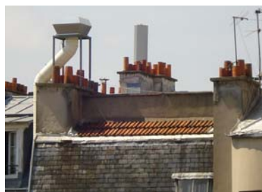
Derrière les cheminées du 43, le montant de l'antenne.
