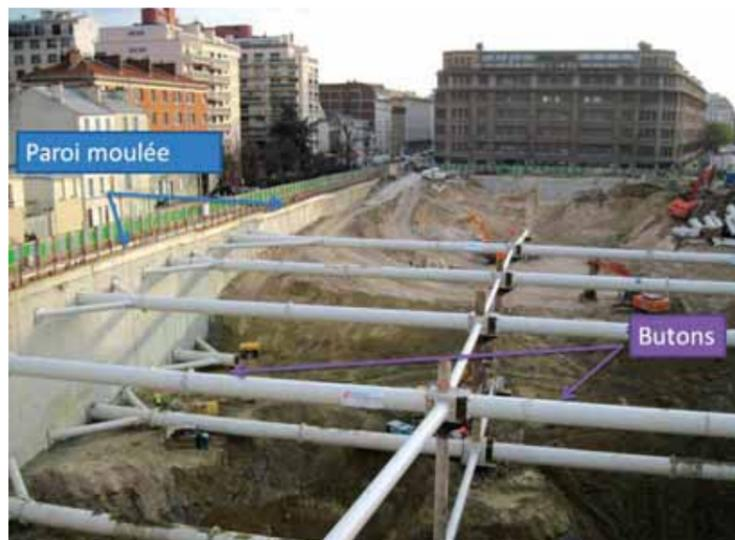
Enfermé dans sa paroi périmétrique moulée, le chantier en est actuellement dans la phase terrassement et butonnage.
