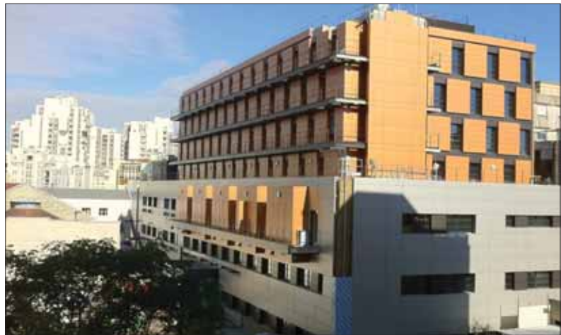
Le nouveau bâtiment rue d'Avron
