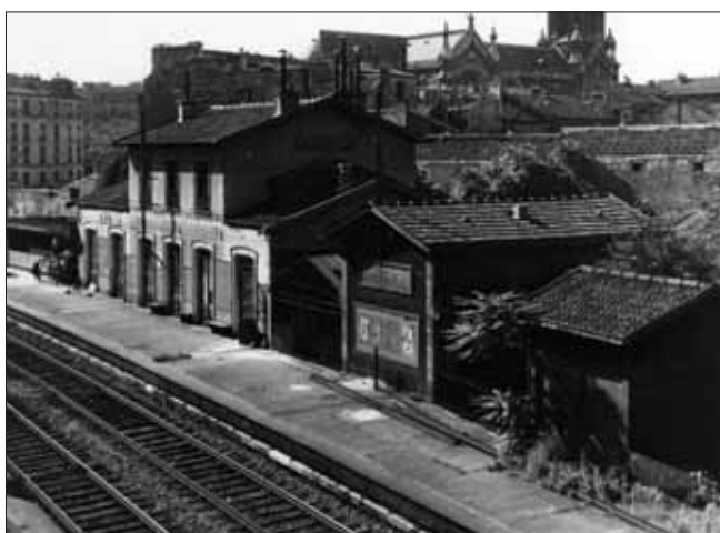
La gare de Ménilmontant en 1950
