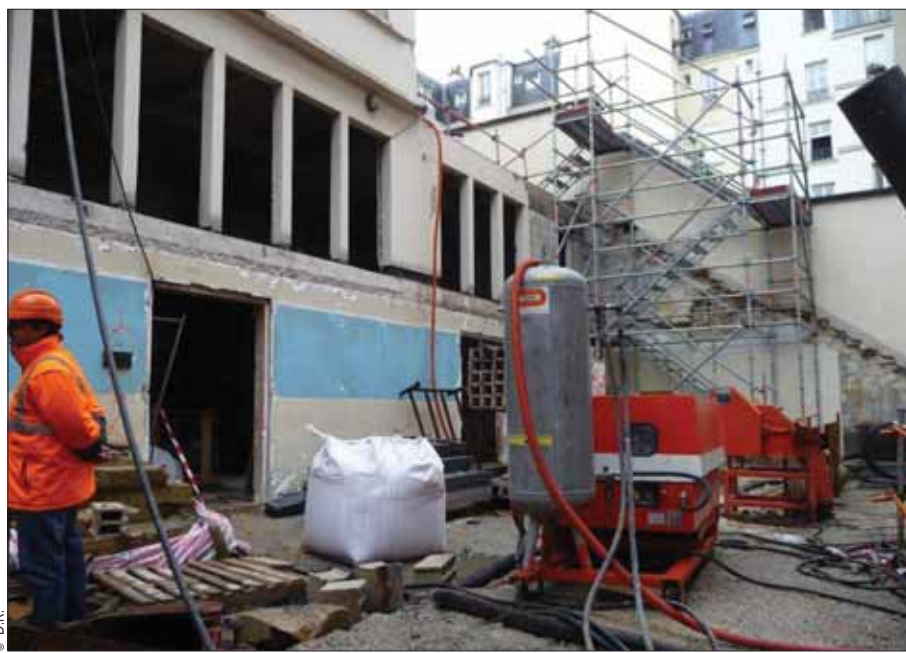
Vue du chantier.
