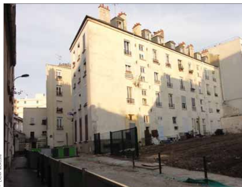
Rue du Guignier, les travaux préalables à la construction d'une nouvelle crèche sont bien entamés.
