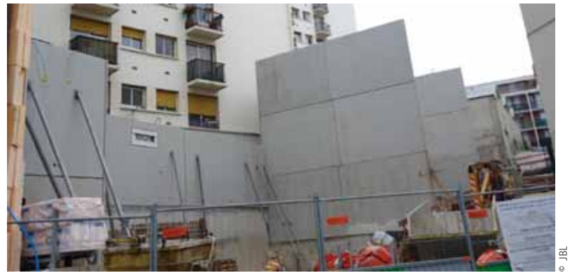
Chantier passage de La Duée
