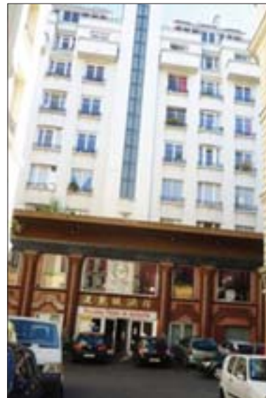
L'immeuble construit à l'emplacement de Théâtre
