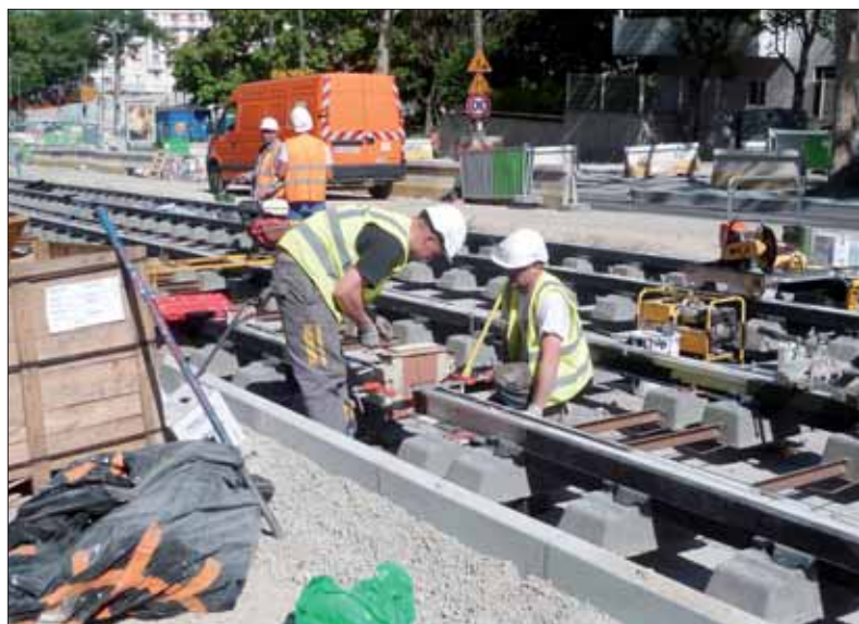
L'installation du moule demande beaucoup d'attention. Ici boulevard Serrurier en mai 2011
