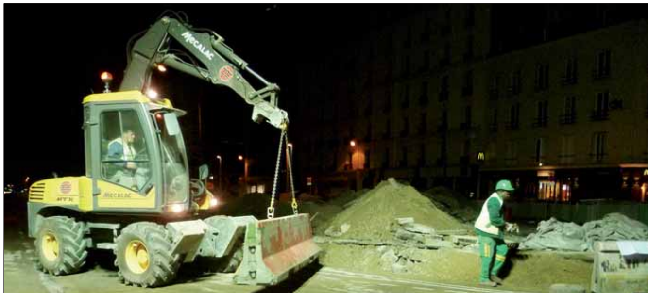
En prévision de l'aménagement du Cours de Vincennes, la mise à niveau de la chaussée a nécessité une nuit de travaux avec arrêt de toute circulation.
