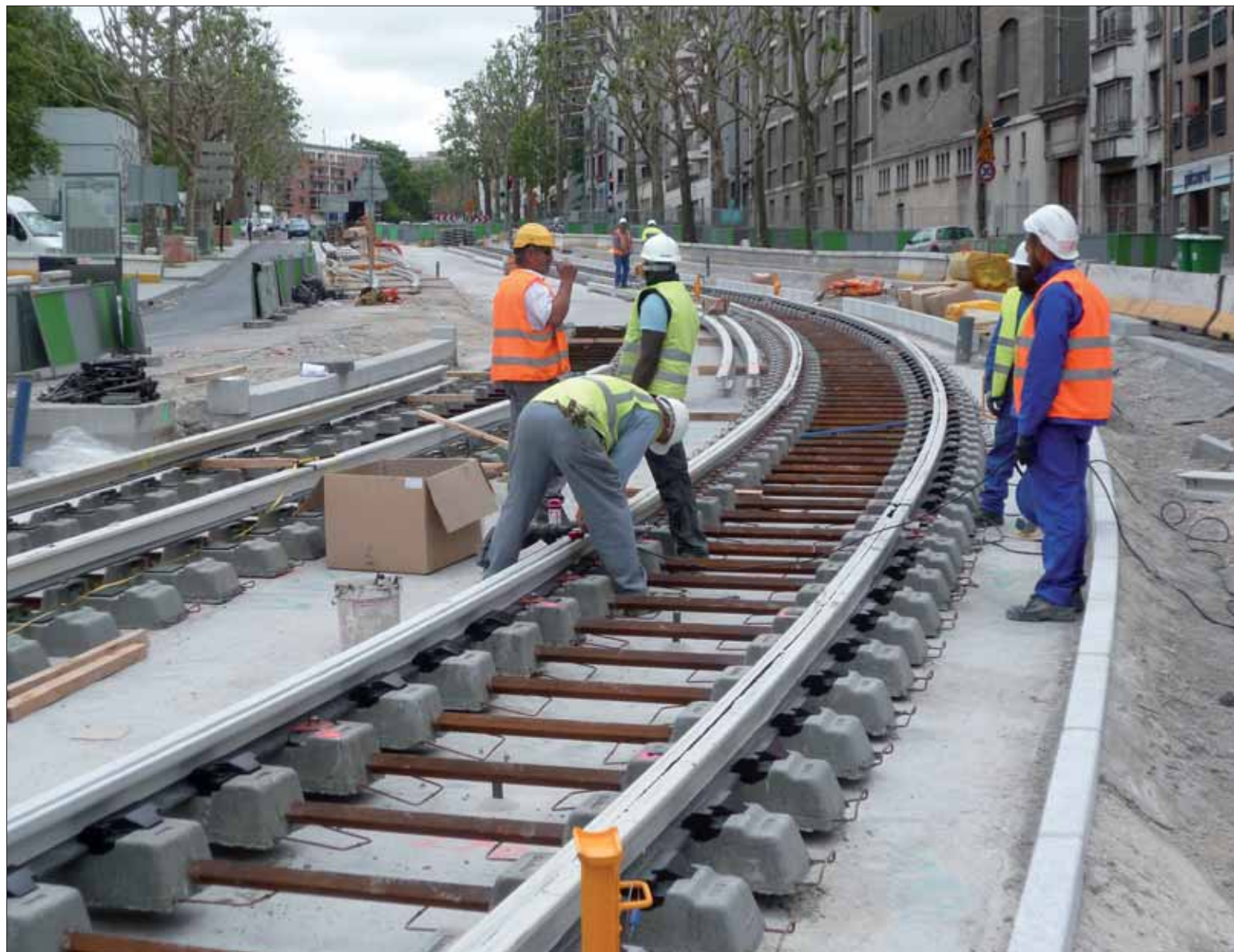
Mise en place des rails du T3 boulevard Serrurier
