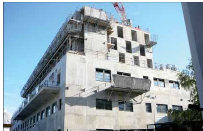
Hôpital de la Croix-Saint-Simon : le gros œuvre du futur bâtiment du site Avron est terminé. Il permettra de regrouper de nombreuses spécialités à compter de l'an prochain.
