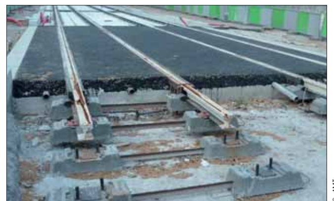
Plate-forme en cours de réalisation.
