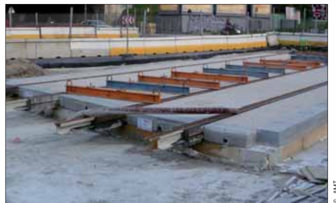
Porte Chaumont, la plate-forme préfabriquée en cours d'installation.
