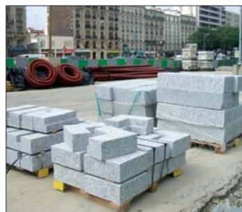
Taillé en pavés, en bordures de fosses d'arbres et en bordures de trottoirs, le granit chinois qui a été transporté par bateaux jusqu'à Marseille et remonté en chemin de fer jusqu'à Bonneuil, arrive sur palettes, là où on en a besoin.
