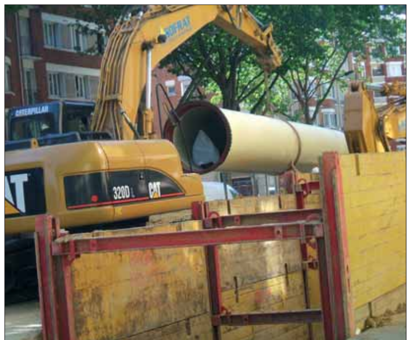
Longs de 8,40m avec un diamètre de 1,20 m : la pose des tuyaux pour l'alimentation en eau potable implique une grande précision. Raccordement et pente oblique, elle se fait au millimètre près.
